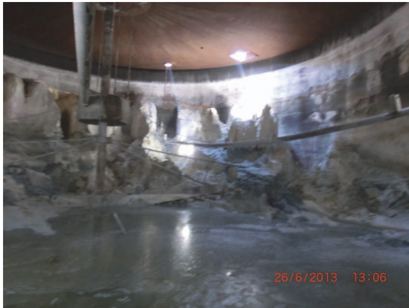
Figure 1. Bac de stockage des boues de la papeterie
